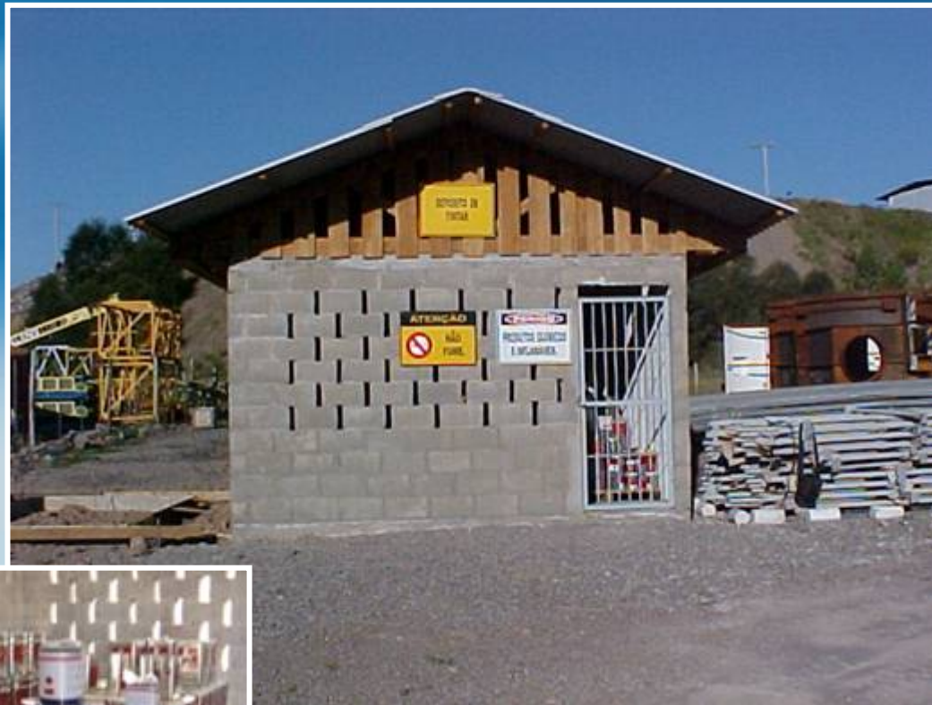
Pátio da eletromecânica
