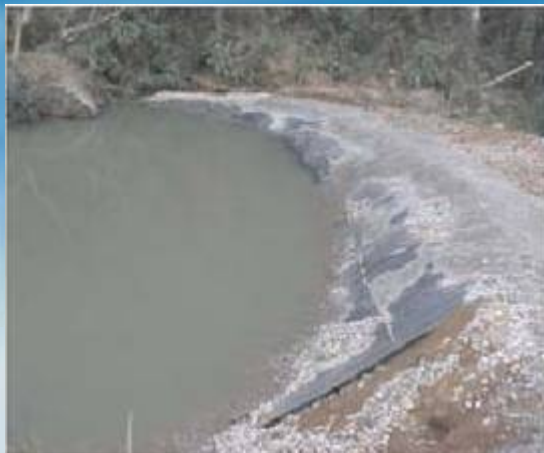
Barragem de Captação do aranha
