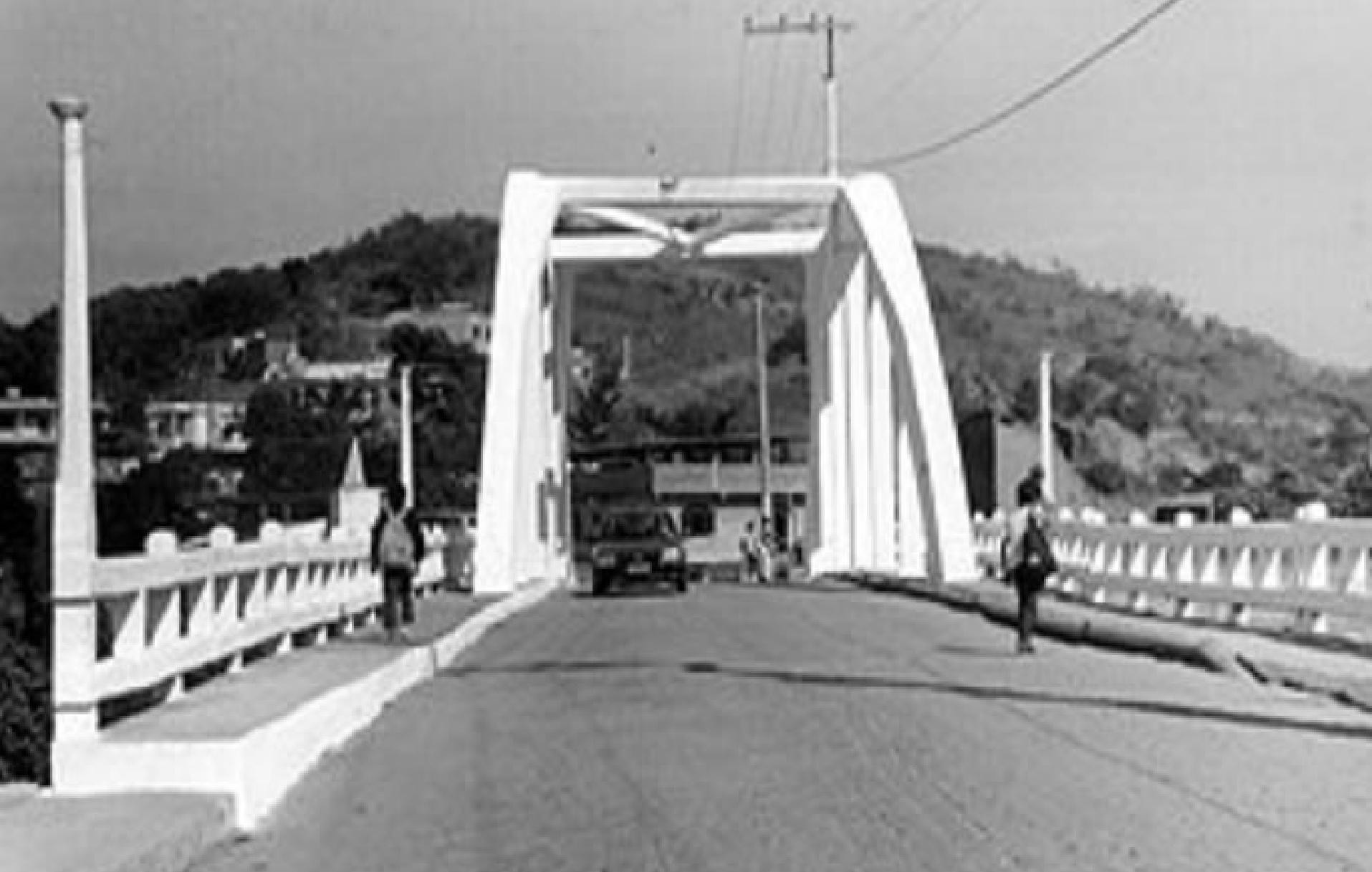
Ponte do Arco
